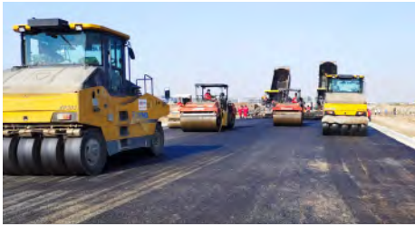
响水不锈钢交易市场施工项目 客户名称：中交三公局第三工程有限公司 项目类型：大型场道园区 项目地点：江苏盐城
