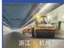
杭州市艮山东路 过江隧道项目
