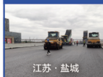
盐城快速路及基础设施项目 北环枢纽工程
