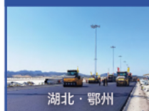
鄂州民用机场工程飞行区 场道工程
