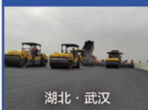
G347武汉新洲段 （内园滩至红岭）改建工程
