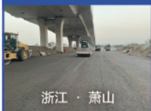
03省道东复线高架南延 工程第1标段
