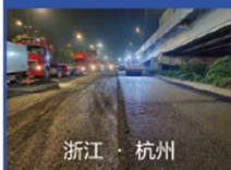
杭州下沙路与12号路 提升改造工程
