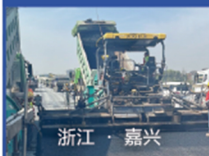
320国道（凤鸣至大麻段） 改建工程
