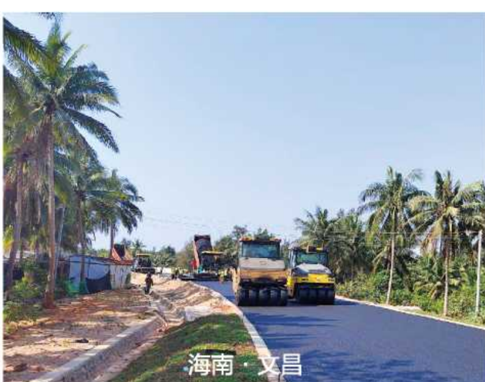
海南·文昌 海南环岛旅游公路文昌段 第一区项目
