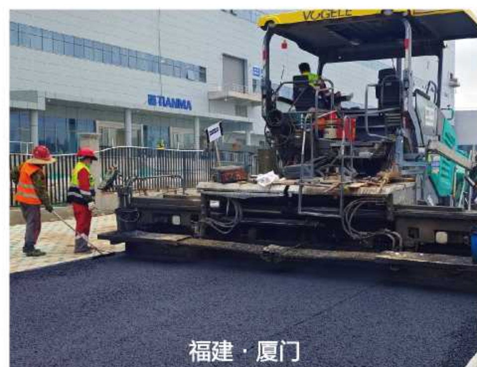
福建·厦门 厦门天马显示科技 生产线项目
