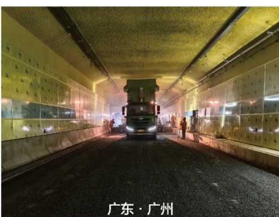
广东·广州 广州国际创新城金光东隧道 工程项目
