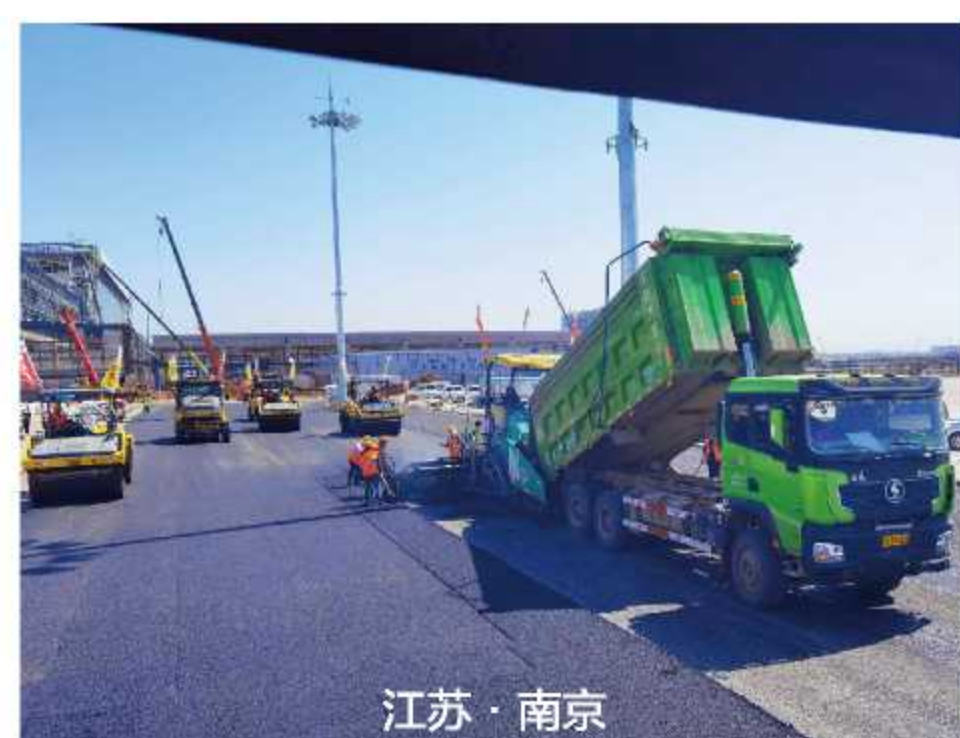
江苏·南京 南京机场跑道 修建项目
