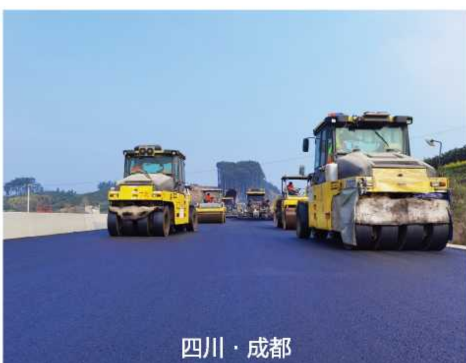
四川·成都 蒲丹快速路（S401蒲江绕城段） 项目
