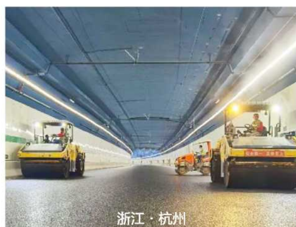
浙江·杭州 杭州市民山东路过江 隧道项目
