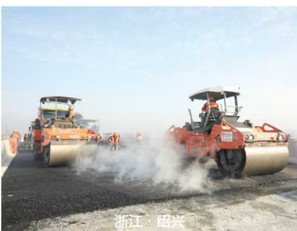
浙江·绍兴 绍兴市越东路及南延段智慧 快速路工程项目
